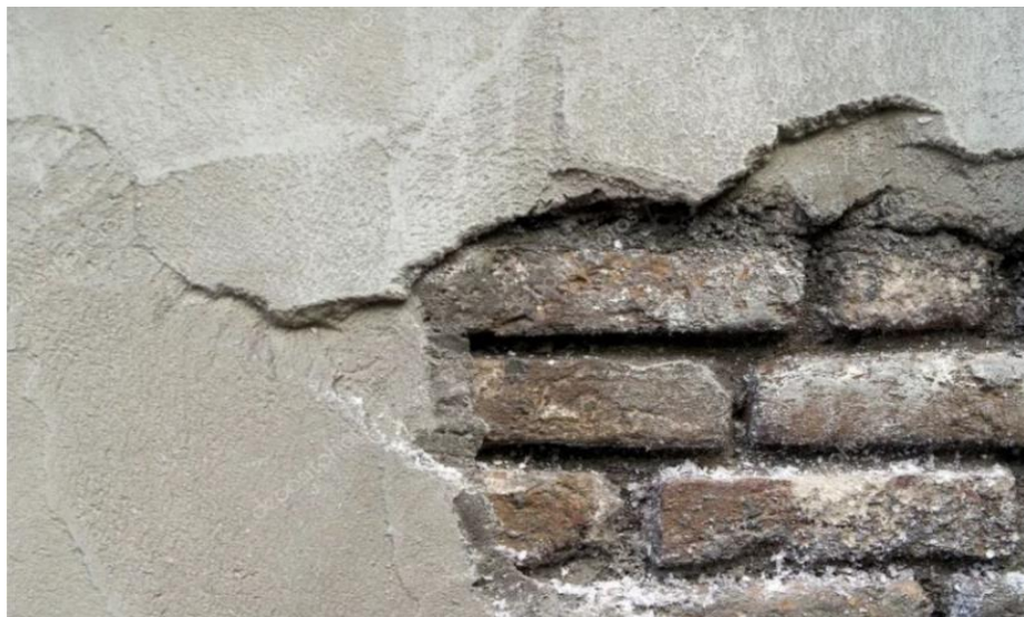
1-rasm. Grunt namligidan namlangan tashqi devor
