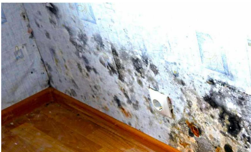
2-rasm. Namlangan tashqi devor ichki sirtidagi mog'or va qo'ziqorinlar
