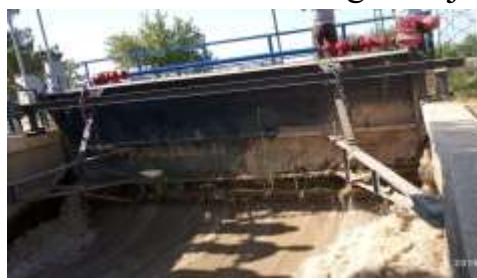
2-rasm. Gidrouzeldagi segmentli zatvor.
